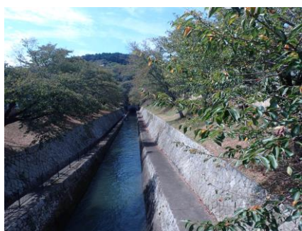
写真（疏水第一トンネル）
